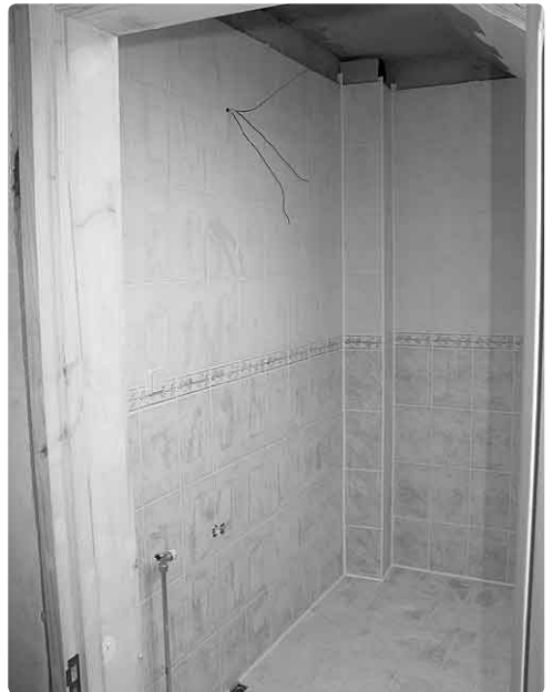
Het betegelen van de doucheruimtes.
